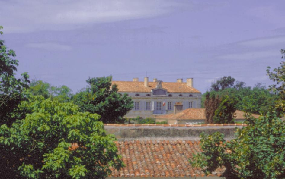
Les toitures sont généralement à double pente. Couvertes en tuiles canal aux chaudes tonalités elles offrent des nuances innombrables qui varient avec la composition et la cuisson. De l'ocre clair au rose lorsqu'elles sont neuves, elles se patinent sous l'action du soleil et des intempéries et prennent alors des tons plus bruns et plus chauds.
