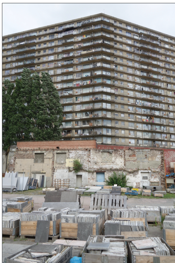
Dépôt ROTOR à Anderlecht (Bruxelles), 2018
