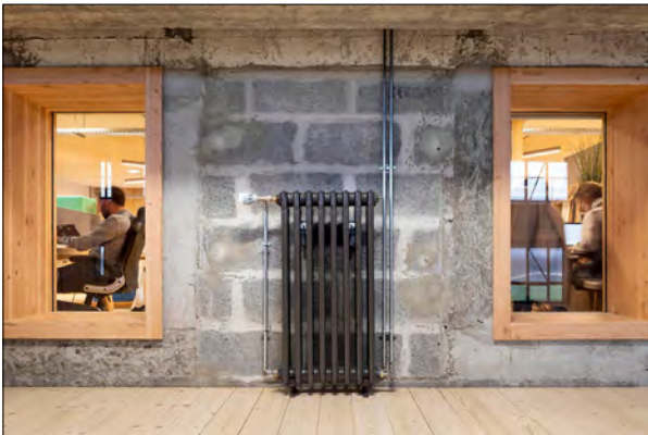
La Grande Halle, Colombelles - Réhabilitation d'une halle industrielle - MO SEM Normandie Aménagement, EPFN / MOE Encore Heureux
