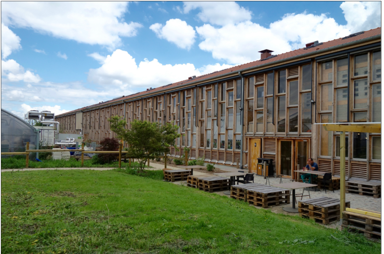
Immeuble Résilience à Stains, Archipel Zéro (Frédéric Denise) architectes, 2021
